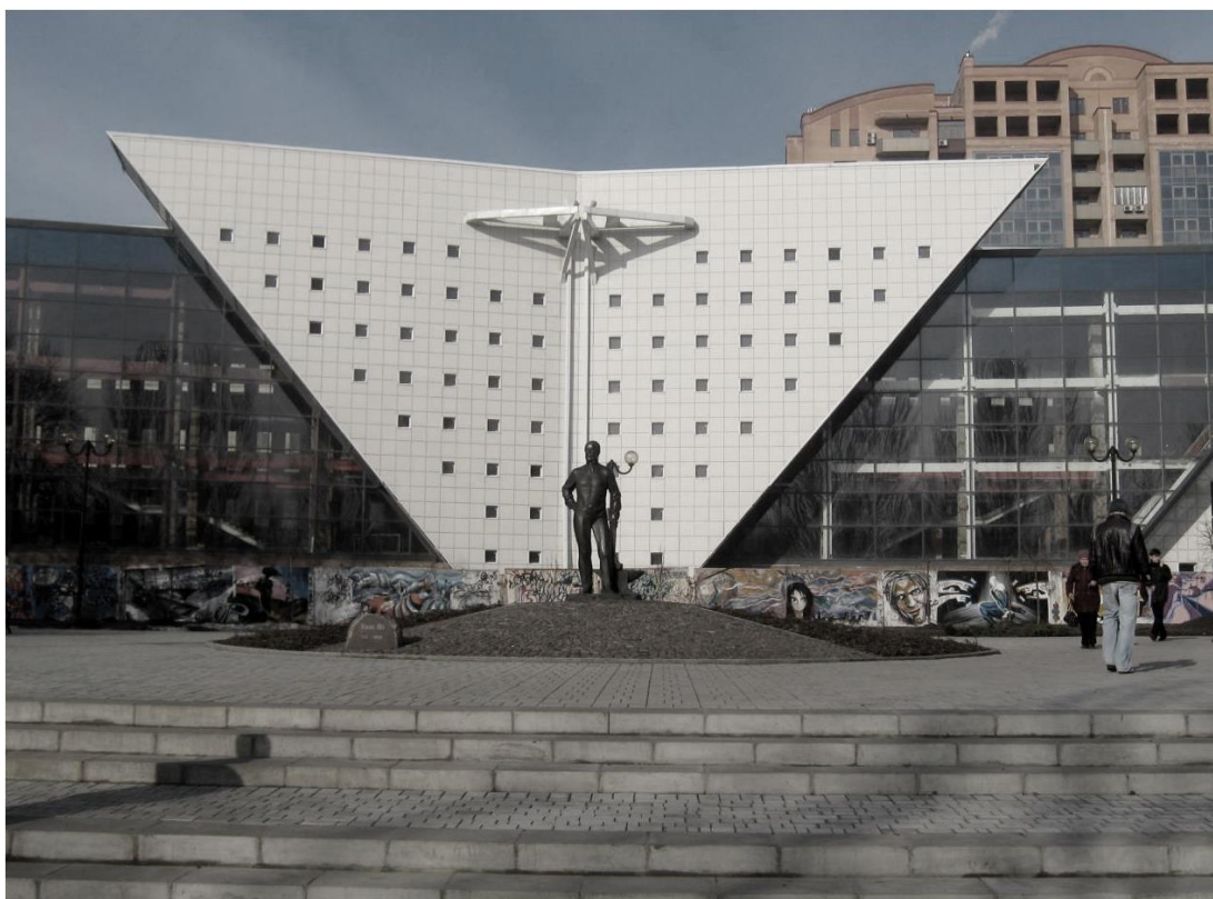
Budynek Centralnej Biblioteki Uniwersytetu Technicznego w Doniecku [119]
